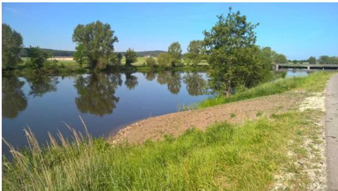
Abbildung 92: Optimal ist ein übersichtlicher und flacher Zugang vom Wasser zu einer Ablenkungsfläche. Es sollten möglichst wenig Bäume und Büsche die Sicht versperren. Der stark verkotete Fahrrad- und Fußweg am rechten Rand des Bilds zeigt, dass diese Ausstiegsrampe und die rechts davon liegende Ablenkungsfläche am Altmühlsee sehr gerne angenommen wird. Foto: LfL, C. Wagner, 01.06.2017.
