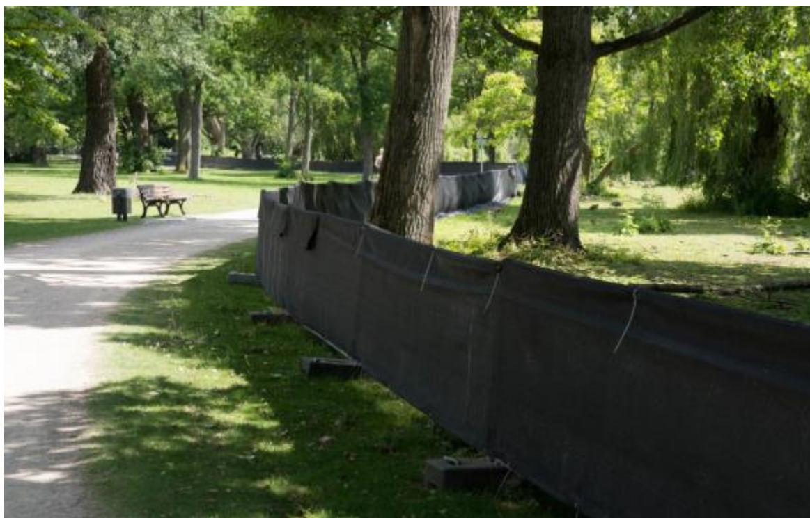
Abbildung 84: Undurchsichtiger temporär installierter Zaun. Da ohne Bodenschluss nur mit eingeschränkter Wirksamkeit. Foto: P. Bozem, 24.06.2018, Frankfurter Ostpark (Stadt Frankfurt).
